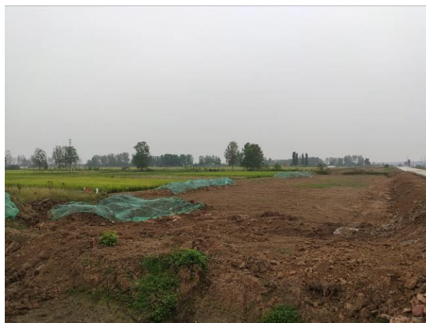
临时堆放表土
