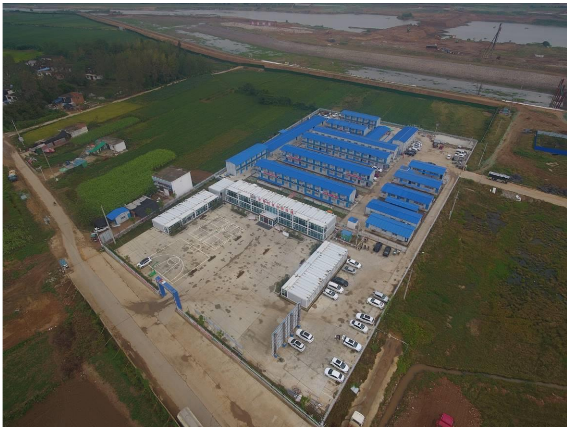
右岸施工生产生活区现场航拍照片
