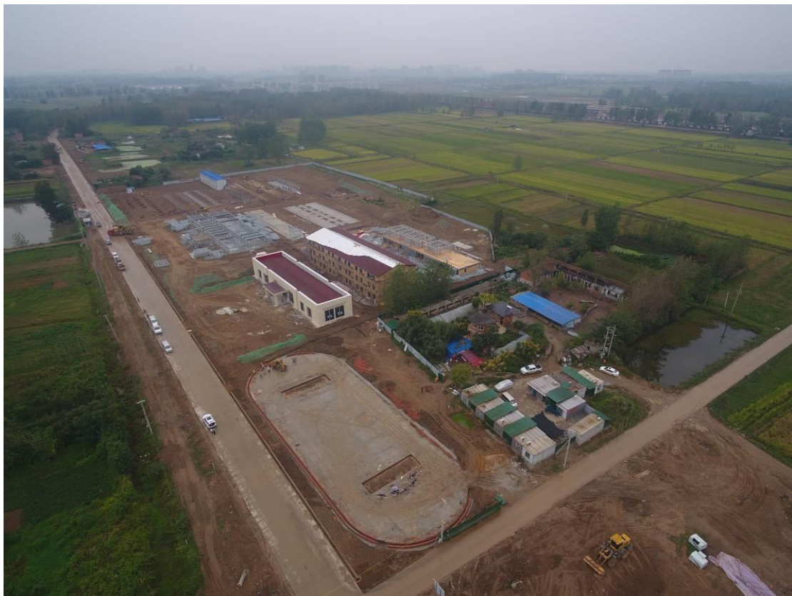
左岸管理房施工现场航拍照片
