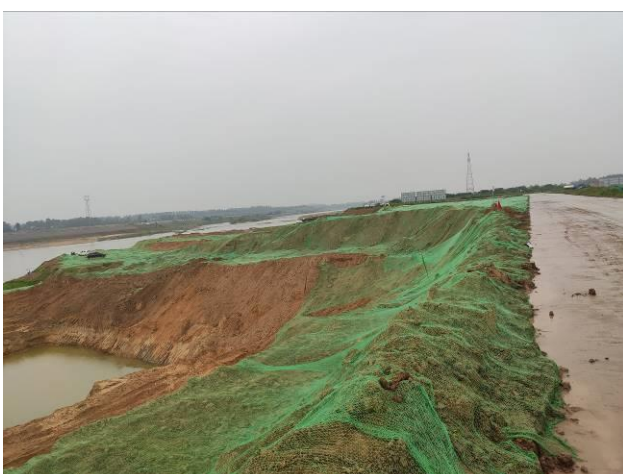
防尘网临时覆盖
