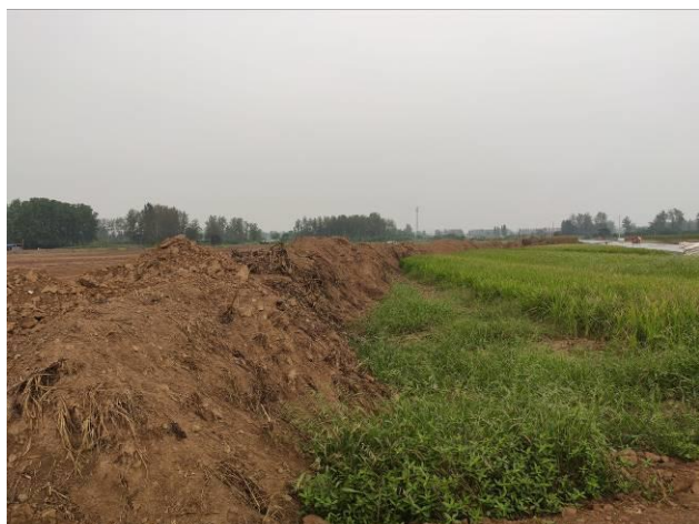
临时堆放表土
