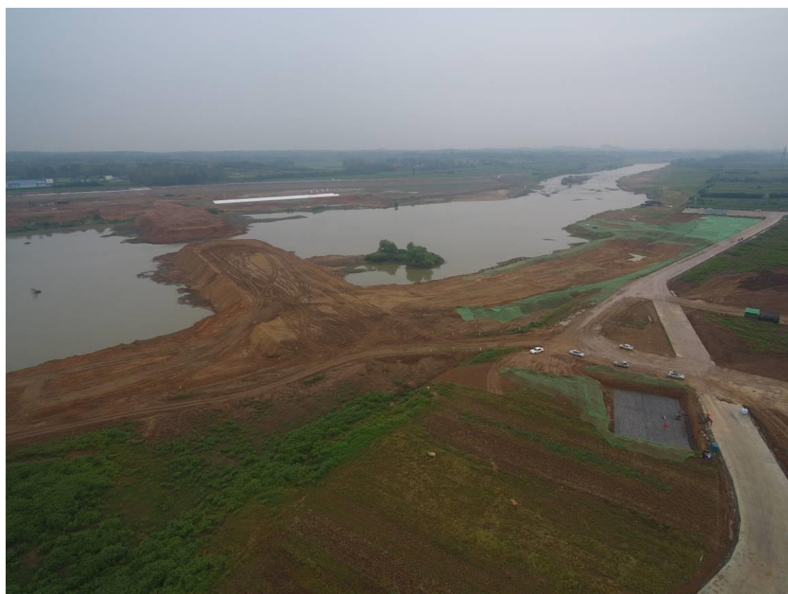
围堰现场航拍照片
