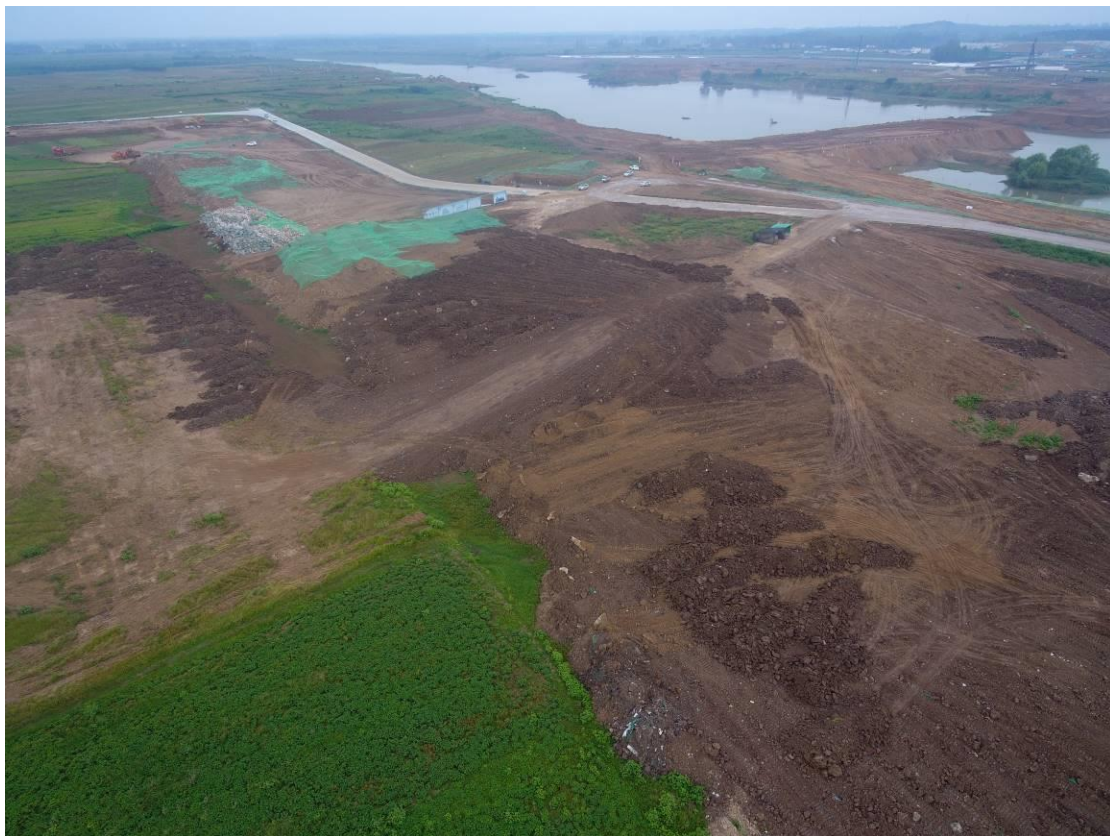
左岸临时堆土场现场航拍照片
