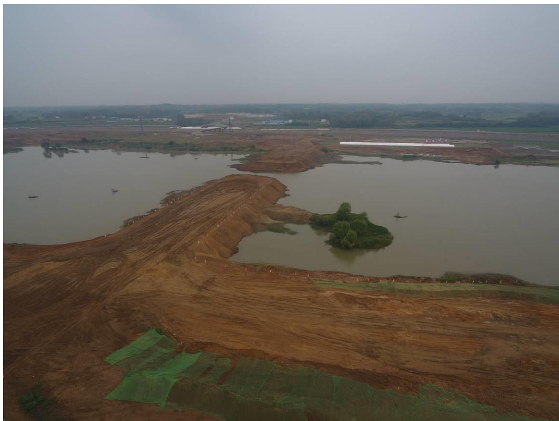
围堰现场航拍照片
