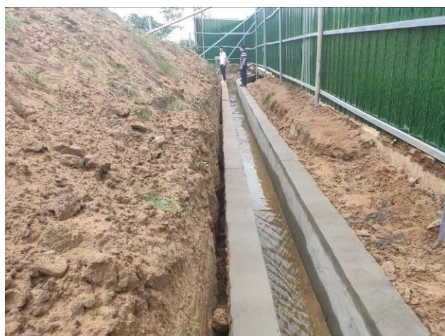
施工道路临时排水沟
