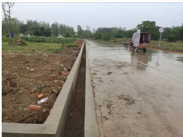
施工道路临时排水沟
