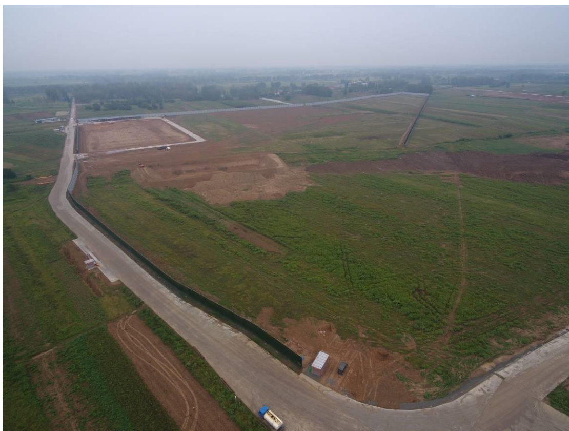
左岸临时堆土场现场航拍照片
