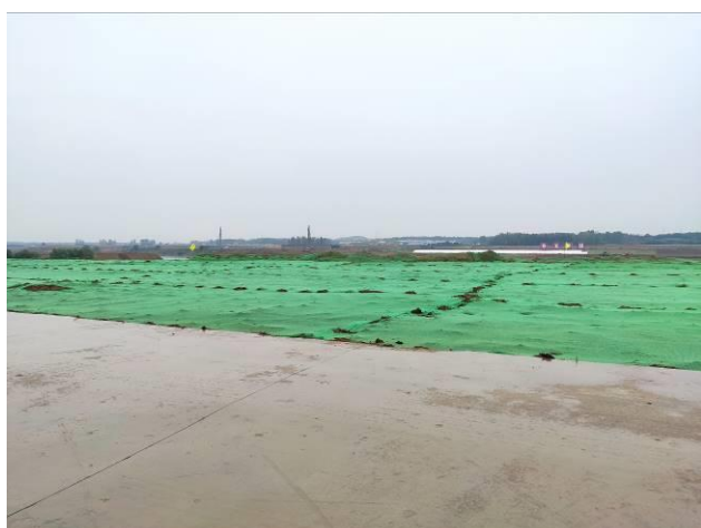
防尘网临时覆盖
