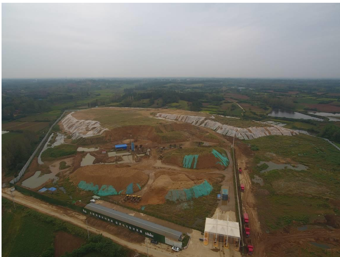
右岸临时堆土场现场航拍照片
