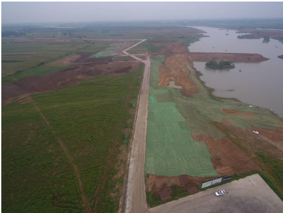
左岸施工道路现场航拍照片
