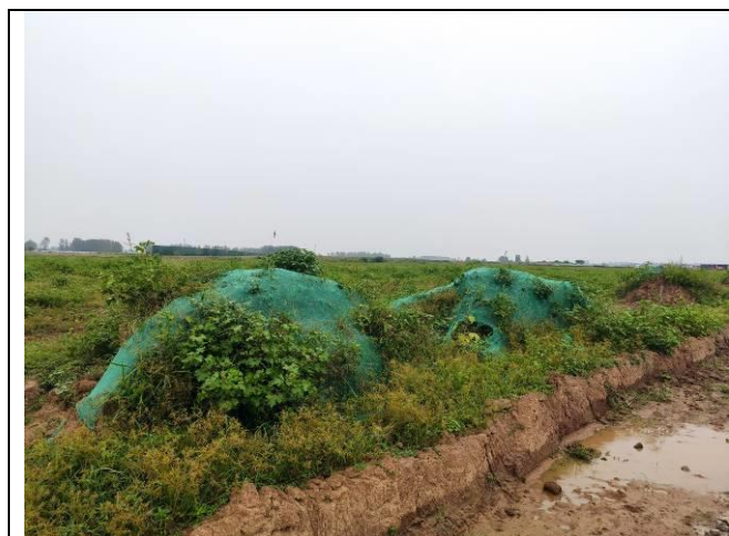
说明：3#路剥离表土，未及时转运
