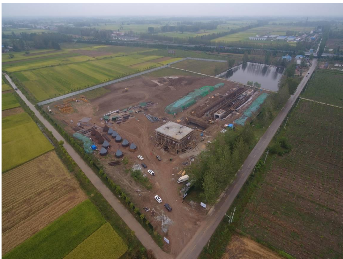
拌合站现场航拍照片
