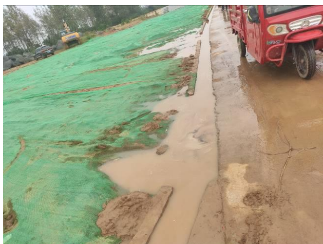
施工道路临时排水沟
