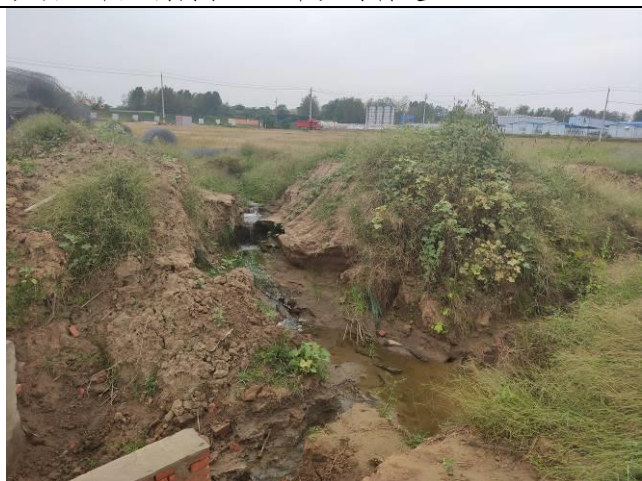
说明：场地内无序排水，局部水土流失严重
