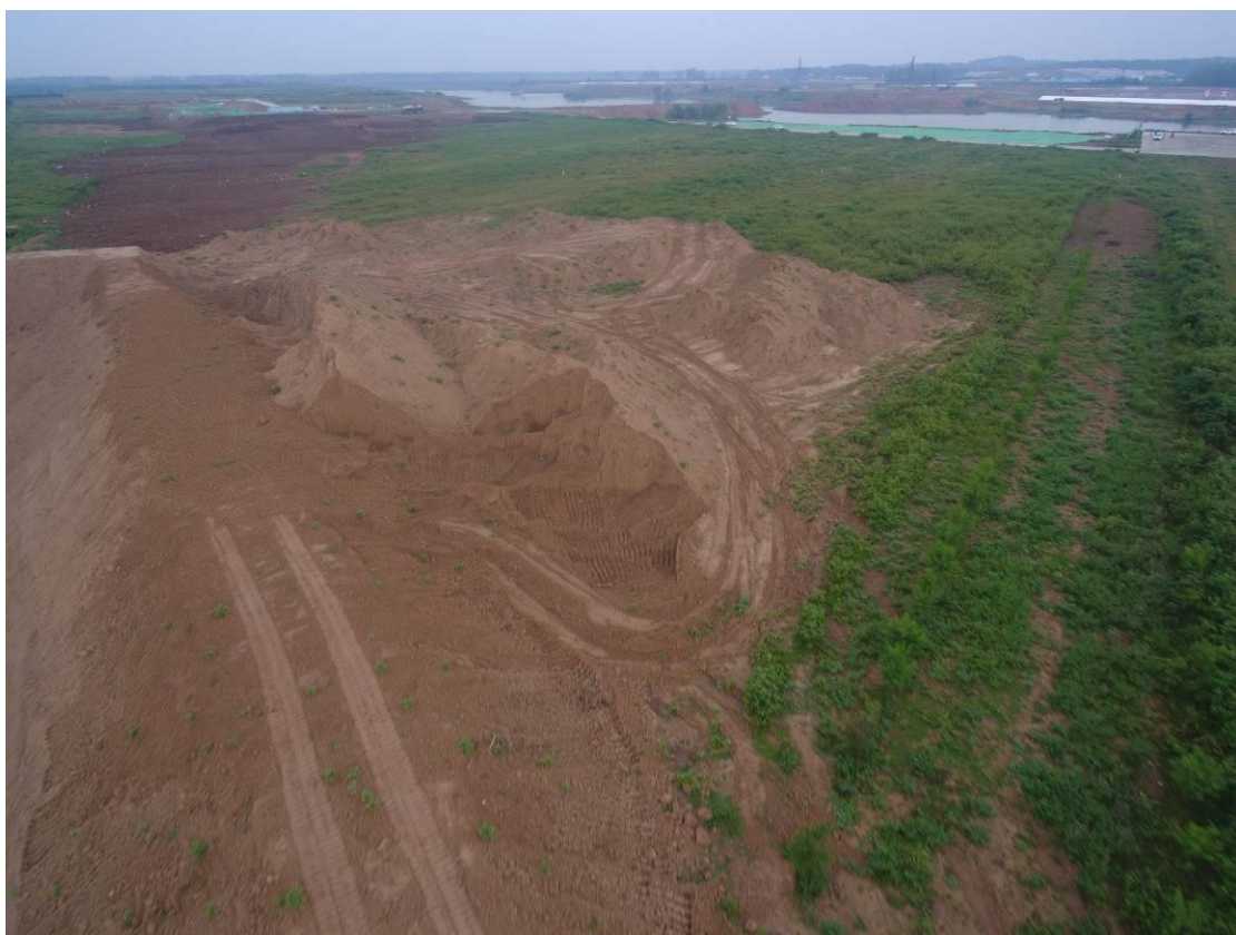
左岸临时堆土场现场航拍照片
