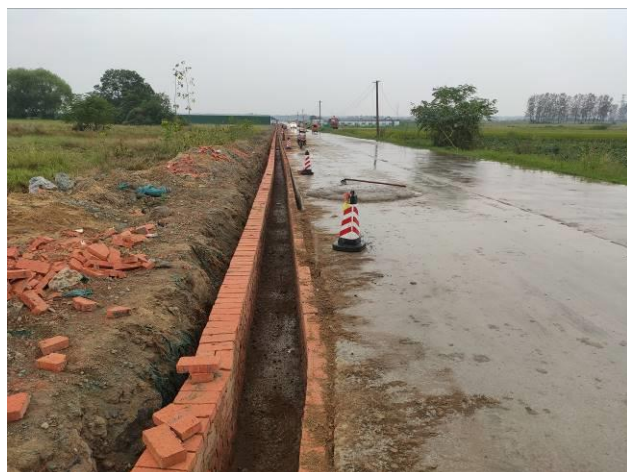
施工道路临时排水沟
